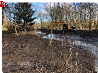
Maintien dans la mesure du possible de la végétation arborée et arbustive en berge
