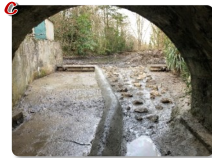
Création d'un merlon pour rétrécir la section d'écoulement en période de basses eaux sous le pont.
