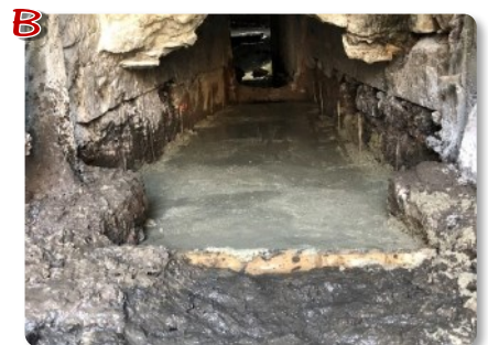
Confortement du canal d'amené après abaissement.
