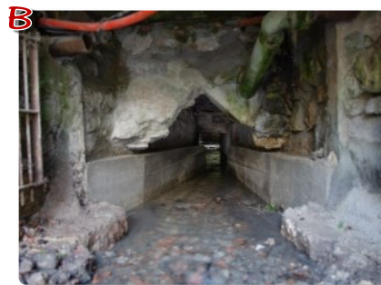
Canal d'amené après travaux de renforcement et remise en eau du bief.
