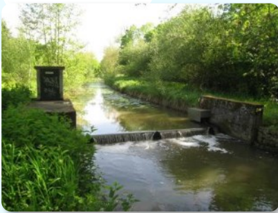
Clapet de la Bédinière en position haute : rupture des continuités écologiques
