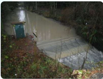
Période de hautes eaux : abaissement automatique du clapet. Permanence de la rupture de la continuité piscicole.
