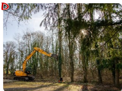
Abatage des peupliers en berges sur le parc communal de la Picardière
