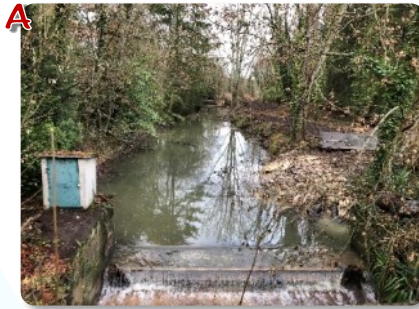
Enlèvement de la partie mobile de l'ouvrage : le clapet abaissant
