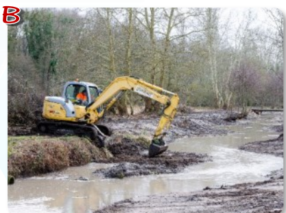
Renaturation du lit mineur par création de banquettes
