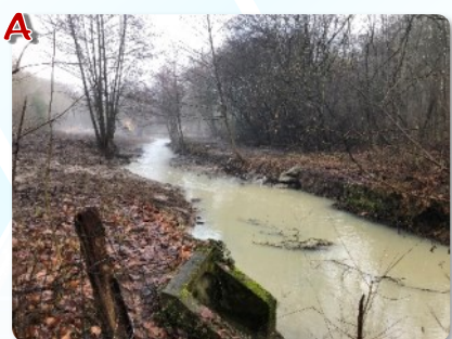
Après retrait complet de l'ouvrage et de ses fondations.
