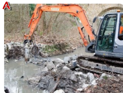
Démolition du seuil de l'ouvrage à l'aide d'un Brise Roche Hydraulique
