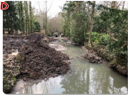
Apport de matériaux pour la création de banquettes en amont de l'ouvrage.
