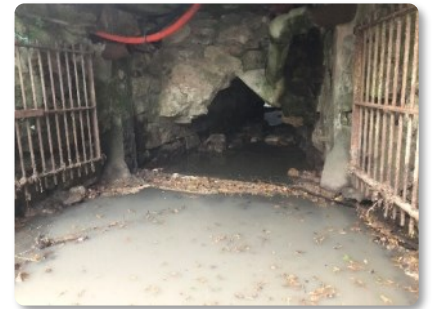
Ouvrage du moulin avant travaux.
