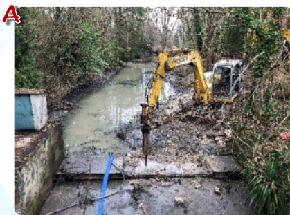
Ouverture de l'échancrure dans le seuil de l'ouvrage à l'aide d'un BRH (Brise Roche Hydraulique)
