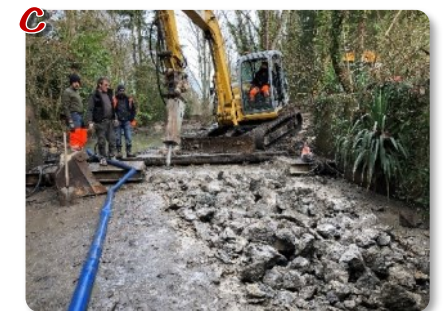
Ouverture d'une échancrure dans le seuil sous la route pour créer une rampe de franchissement plus adaptée.
