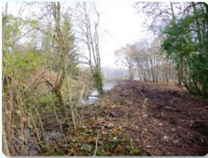
Dégagement d'une voie d'accès jusqu'à l'ouvrage pour les engins de chantier
