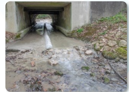
Rampe vue depuis l'aval après remise en eau
