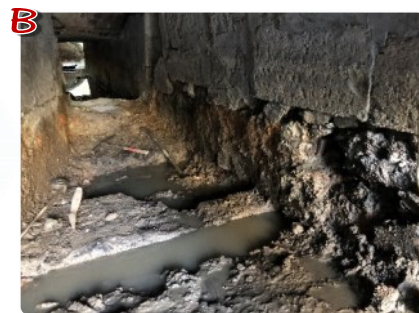
Fondations du moulin empêchant l'abaissement initialement prévu.
