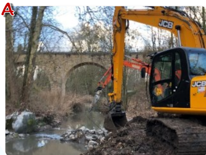
Retrait des culées bétons
