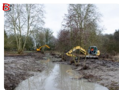
Retalutage des berges
