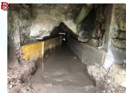
Confortement des parois du canal d'amené après abaissement.
