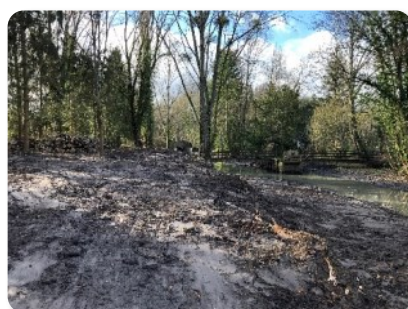
Remise en état de la voie d'accès.
