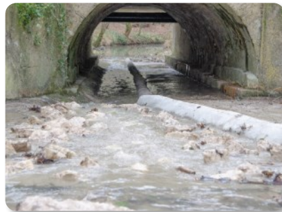
Rampe vue depuis l'amont après remise en eau
