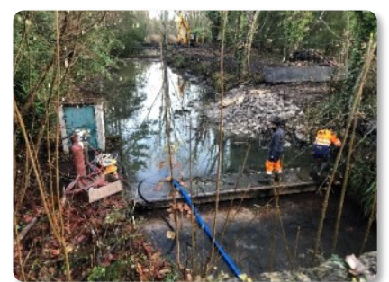
Mise hors d'eau du cours de la Bionne pour intervention sur le seuil de l'ouvrage
