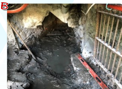
Abaissement du fond du canal d'amené sous le moulin
