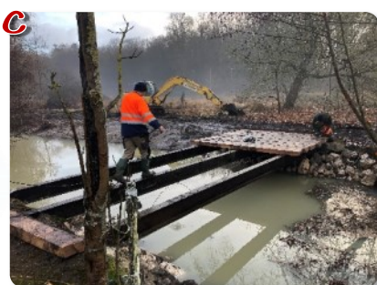
Remise en état de la passerelle
