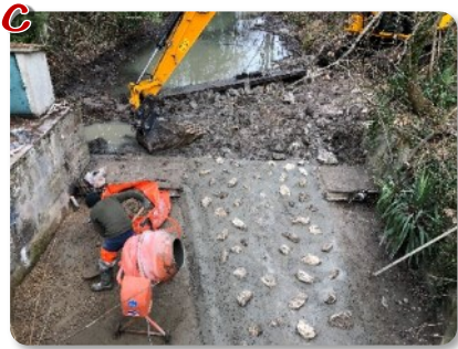
Aménagement de l'échancrure, de la rampe avec des blocs permettant la dissipation de l'eau.
