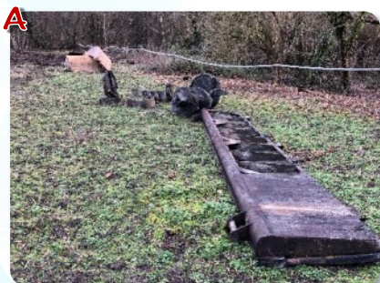
Retrait du clapet et du système hydraulique
