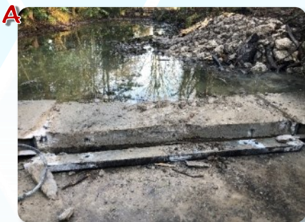
Découpe et retrait des éléments ferreux et début d'ouverture d'une échancrure dans le seuil béton.
