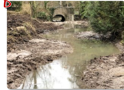
Terrassement des matériaux et création d'un tracé mineur sinueux dans l'emprise du lit mineur avant travaux.
