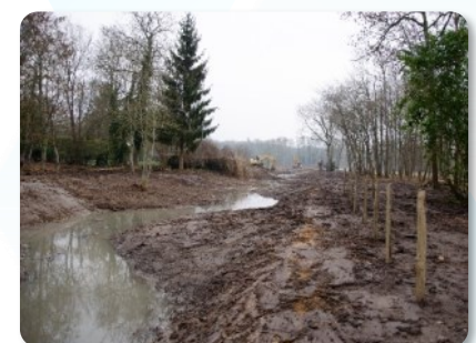
Repose des clôtures existantes avant travaux.
